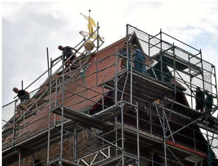
Auf dem Kirchturmdach in Kirchengel steht seit Freitag ein Engel.
