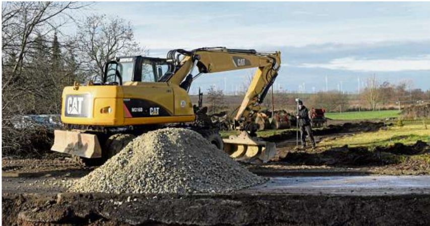
An der Kirchallee in Rastenberg wird ein Seniorenheim gebaut. ARCHIV-FOTO: JENS KÖNIG
