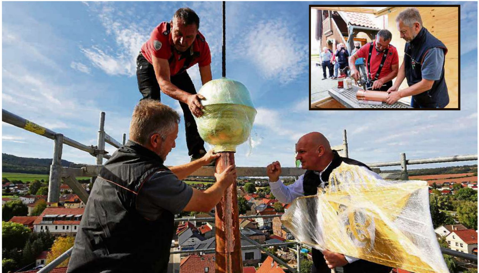
Marco Ritschel von der Restaurierungs- und Bausanierungsfirma BSR-Ritschel aus Gotha (von links), Dachdeckermeister Lars Tukai vom Unternehmen Tukai aus Sömmerda, setzen den restaurierten Turmknopf samt Wetterfahne auf die Spitze des Kirchturmes, behilflich dabei ist in luftiger Höhe Sondershausen Bürgermeister Steffen Grimm (parteilos). Oben rechts: Ritschel und Tukai verlöten die mit Dokumenten und Münzen aus heutiger Zeit neu bestückte Kapsel für den Turmknopf
